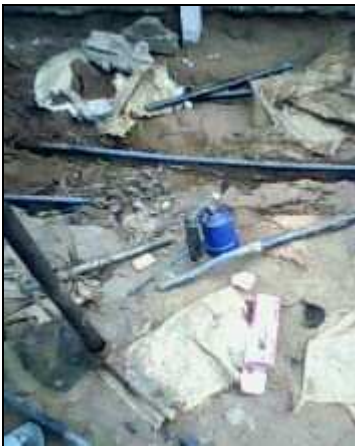
Figure 5: dispositions pour souder un tuyau cassé pendant la nuit durant la chasse à l'eau. Photo : Beugre Stéphane. Copy Right : Pays bas-Gesco
