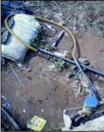
Figure 11 : branchement extraordinaire au compteur d'eau pour pouvoir avoir de l'eau. Beugre Stéphane. Copy Right : Pays bas-Gesco.
