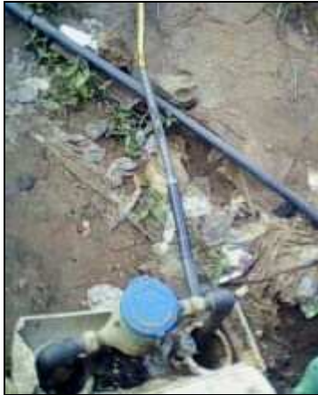
Figure 9: branchement extraordinaire au compteur d'eau pour pouvoir avoir de l'eau. Beugre Stéphane. Copy Right : Pays bas-Gesco.
