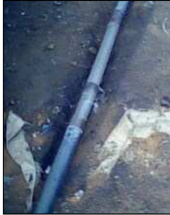
Figure 12: le gros tuyau d'alimentation de la société de distribution d'eau soudé. Beugre Stéphane. Copy Right : Pays bas-Gesco.
